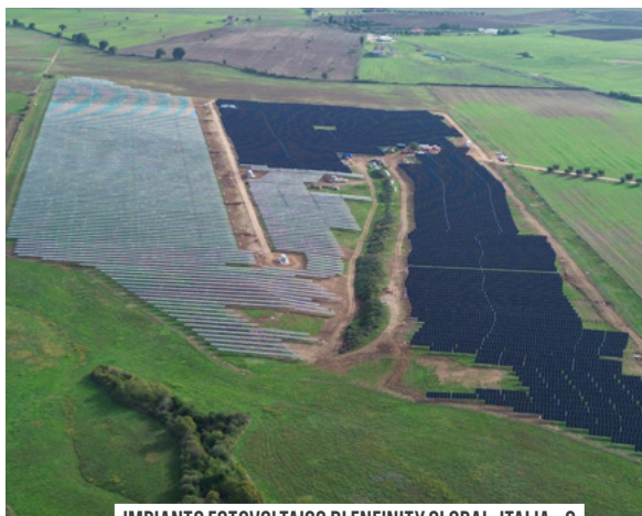
IMPIANTO FOTOVOLTAICO DI ENFINITY GLOBAL, ITALIA - 2
